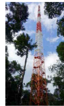
A torre ATTO de 325 metros de altura na Amazônia Central será usada para gases traços, aerosóis e outros, medindo continuamente ao longo dos 5 anos deste projeto
